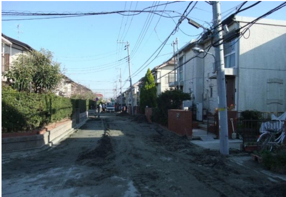
写真-1：東日本大震災（2011/3/11）による宅地の被災事例 （左：埋立て地における地盤の液状化，右：丘陵地における盛土・擁壁の崩壊）
