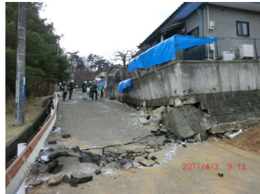
写真-1：東日本大震災（2011/3/11）による宅地の被災事例 （左：埋立て地における地盤の液状化，右：丘陵地における盛土・擁壁の崩壊）
